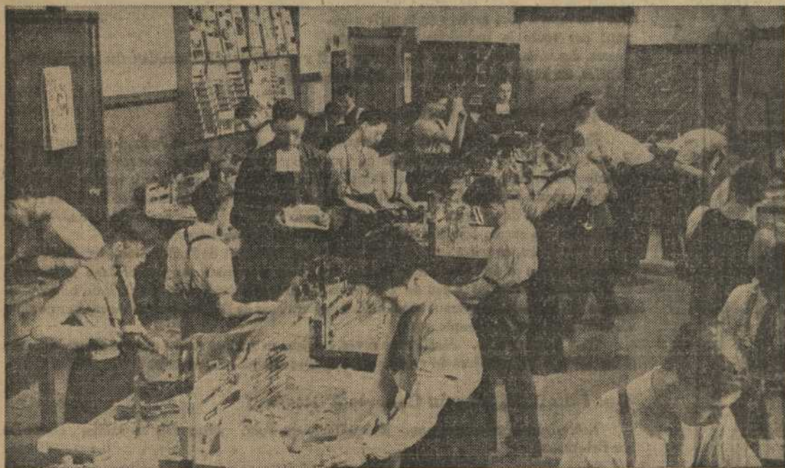
Classe de travaux manuels à Saint-Sauveur. Professeur, F. JULIEN
