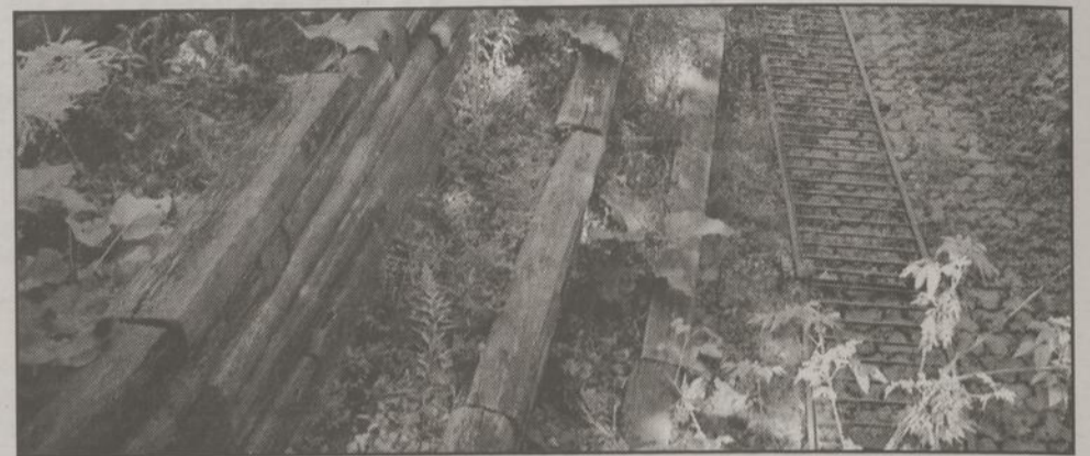
Tout a été arraché à cette descente conduisant au sous-sol du centre. Ce sont maintenant des cyclistes qui y réalisent des exploits.
