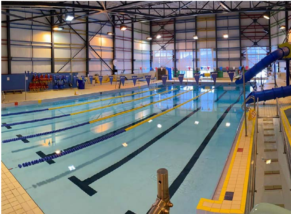
La piscine de Sainte-Julie a été inaugurée en 1995. (Photo : courtoisie)
