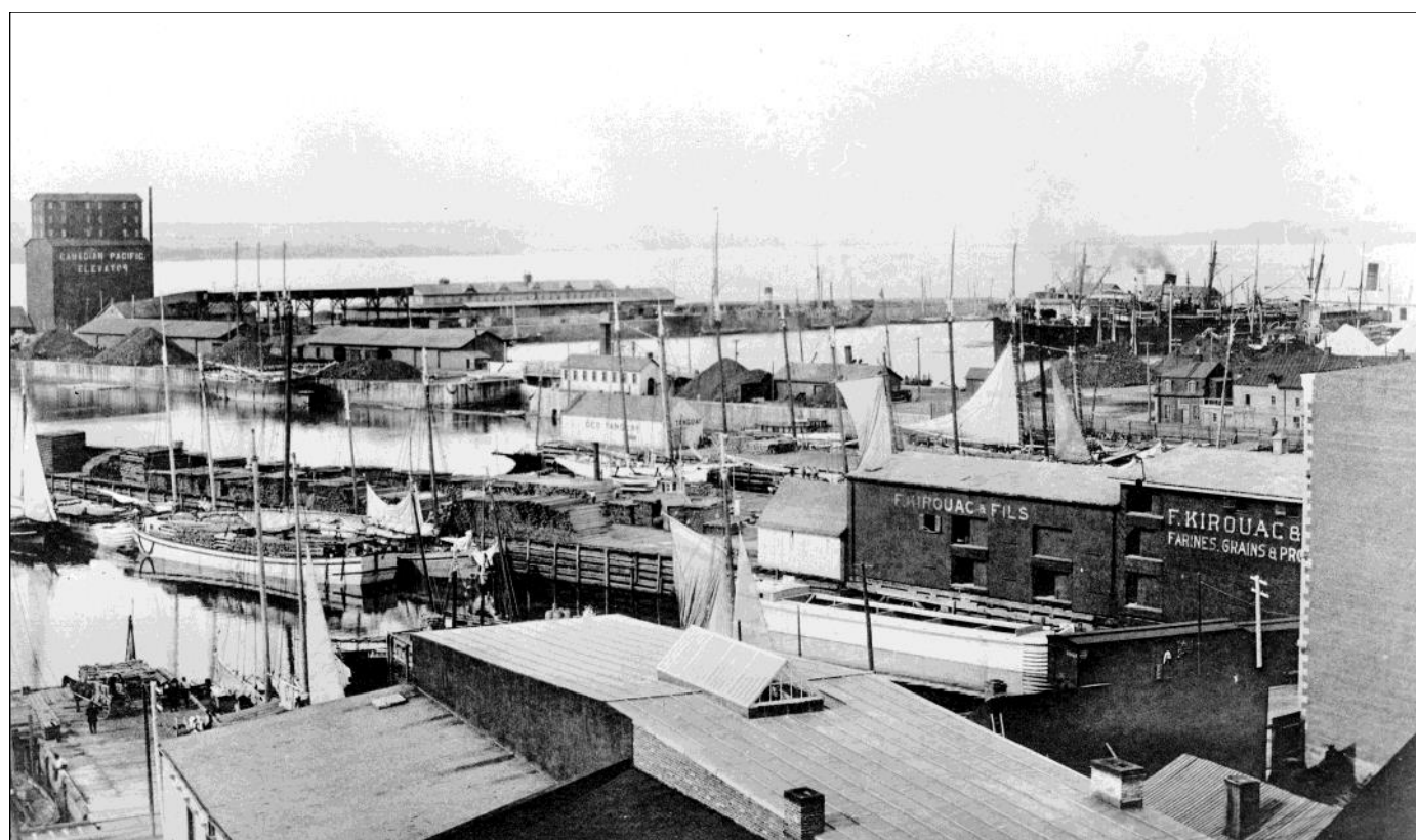
Entrepôt de la maison F. Kirouac & Fils , vu depuis la rue des Remparts, dans le bassin Louise à Québec à la fin du XIX e siècle. (L'image est tirée de l'ouvrage " Art Work of Québec, 1899, gracieuseté du département des archives de la ville de Québec.)
