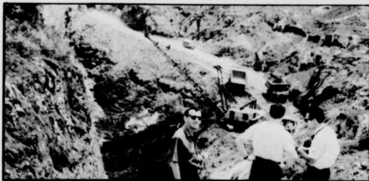
Une des mines de bauxite à ciel ouvert, appartenant à l'Alcan.
