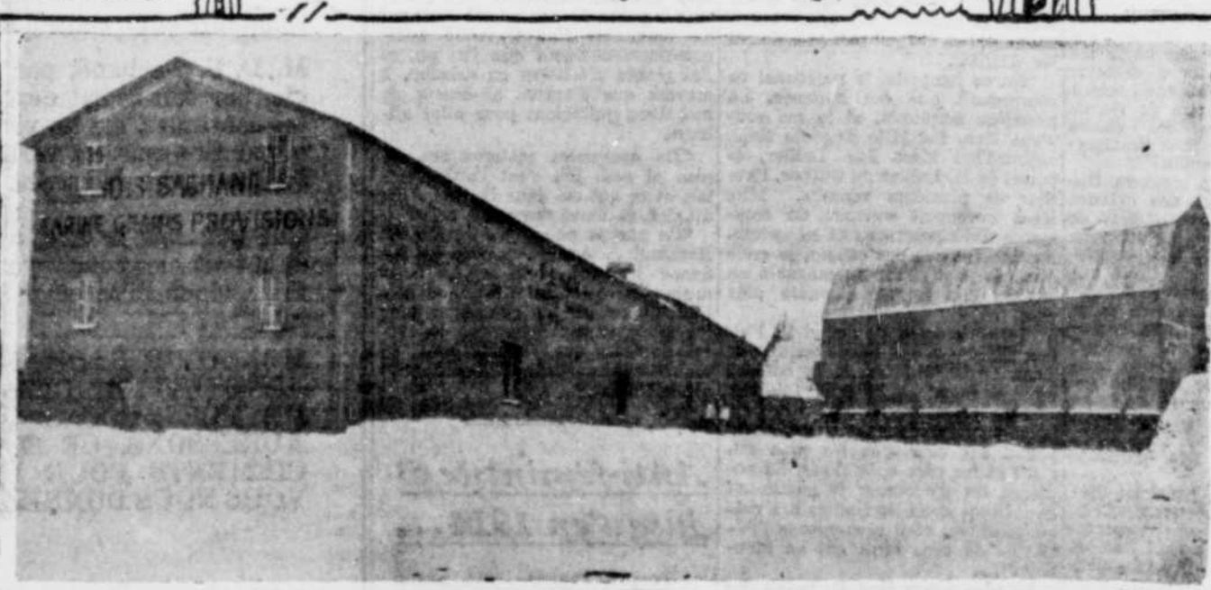
Un des entrepôts
