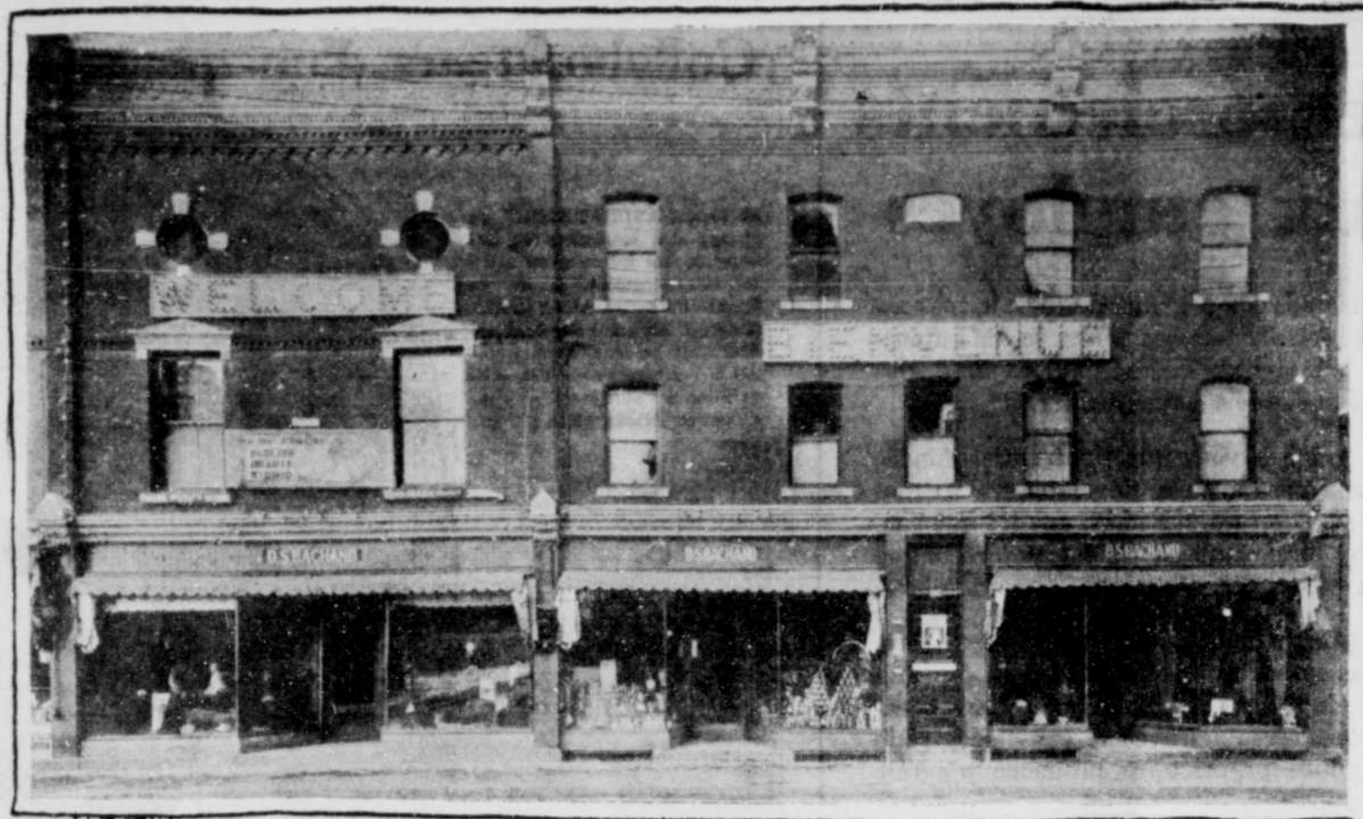
Vue générale du Magasin
