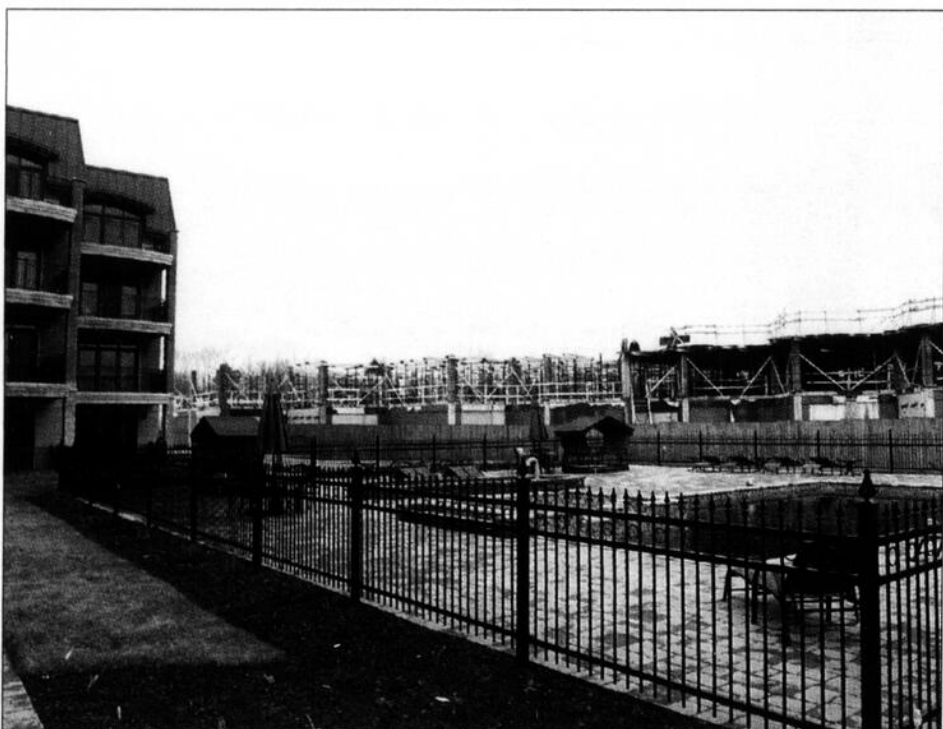
Les travaux de construction de la seconde tour, qui ont débuté la semaine dernière, devraient être complétés au printemps 2011.
