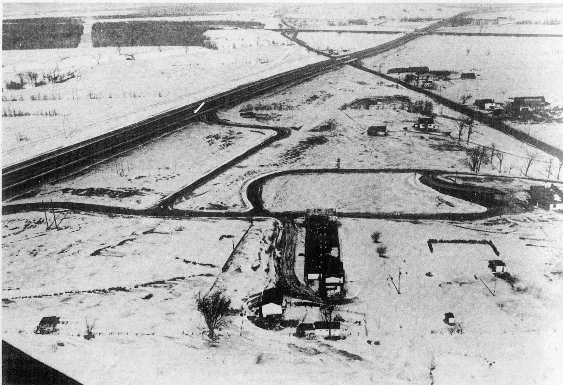
CETTE PHOTO AERIENNE illustre on ne peut mieux l'inutilité des travaux de la Voirie. Au premier plan, le motel Nagine. La nouvelle route permettra aux automobilistes qui roulent sur la 540 (à gauche de la photo) de se rendre au motel et d'en repartir. C'est la seule utilité des nouveaux travaux. Plus tard, la liaison sera faite entre la 540 et la 17. Mais elle existe déjà 3/4 de mille plus loin, grâce à l'échangeur qu'on distingue au-delà du 2e viaduc. Les usagers de la 17 deviendront sûrement les automobilistes les plus gâtés de la province.
