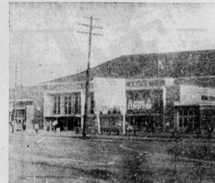
L'ARENA DE SUDBURY VU DE L'EXTERIEUR — Situé en face de la gare du Pacifique-Canadien, angle des rues Elgin et Minty, l'arena de Sudbury est très facile d'accès. A proximité de cet amphithéâtre se trouvent plusieurs terrains de stationnement. L'arena de Sudbury est une entreprise municipale qui a été achevée en 1951. A l'entrée
