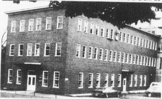
Cette partie de l'édifice sera conservée pour abriter les bureaux administratifs entre autre. A l'entrée, les pancartes T. Antonio Fournier et Fortan ont cédé le pas à celle de A.C. Assouad Canada Ltée. [Photo JF]
