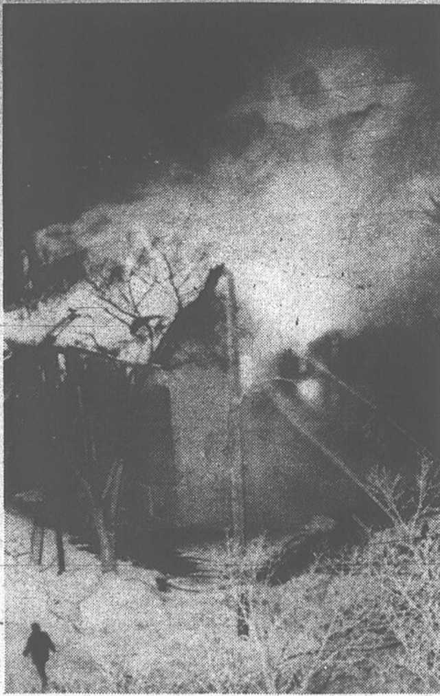
Sept personnes au moins ont péri dans l'incendie qui a détruit cet immeuble de 31 appartements, à Winnipeg.
