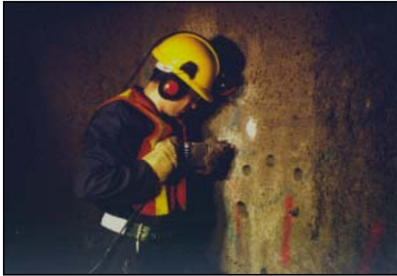
Figure 5.4: Exemple type du polissage de la surface du béton projeté.
