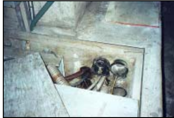
Figure 5.10: L'emplacement des conduits électriques dans la plate-forme du métro.
