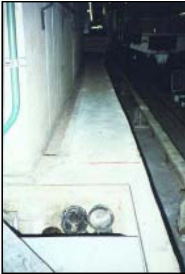
Figure 5.10: L'emplacement des conduits électriques dans la plate-forme du métro.
