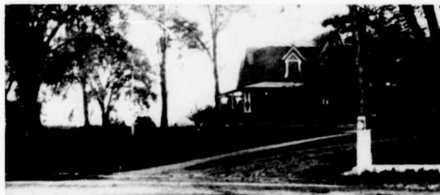
Résidence des Valois, emplacement actuel de l'Eglise St-Jean-Baptiste, (le Boul. Harwood n'existe pas).
