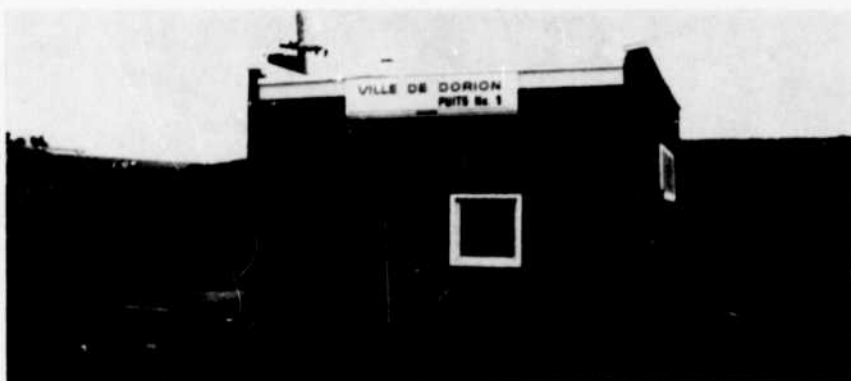
Puits No 1, (Robillard) et Puits No 4, Chemin St-Antoine.
