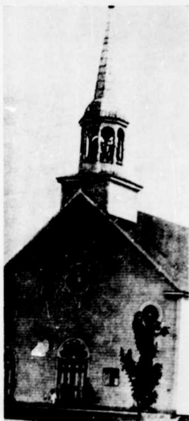
La première chapelle avec son clocher effilé, rue de l'Eglise antérieurement en 1930.
