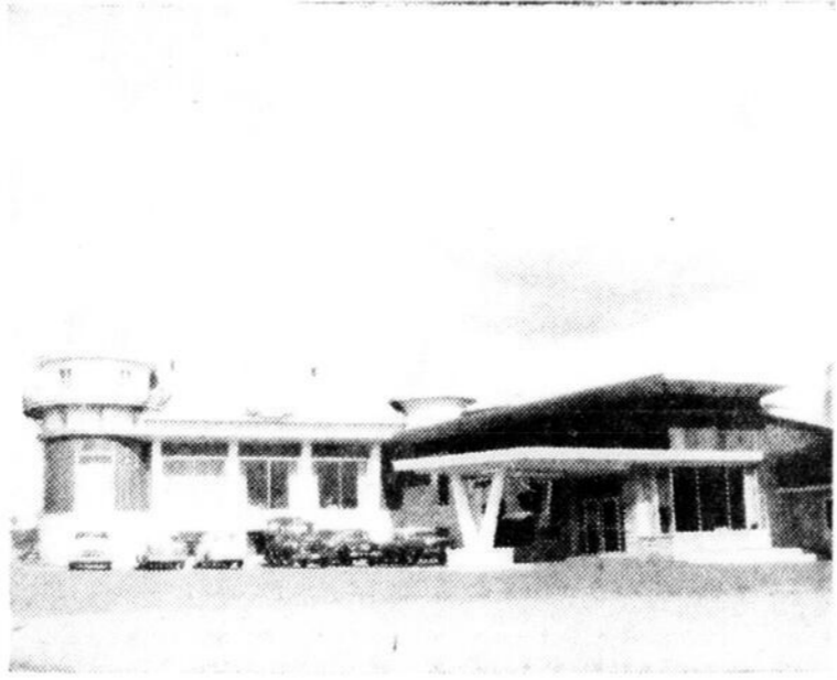
Parmi nos principaux fournisseurs nous comptons Adelaïde Laberge Ltee qui ont fait la toiture, le fer ornemental, l'air climatisé, le chauffage, la ventilation et la plomberie. La Vitrerie Citadelle Inc. a fourni le verre des fenêtres et les miroirs. L'enseigne principale est l'œuvre de Trans-Canada Sign. Nos courtiers en assurances sont J. A. Mainguy & Fils et Houle & Gauthier Ltee. M. Narcisse Guay contracteur dirigeait les travaux.
