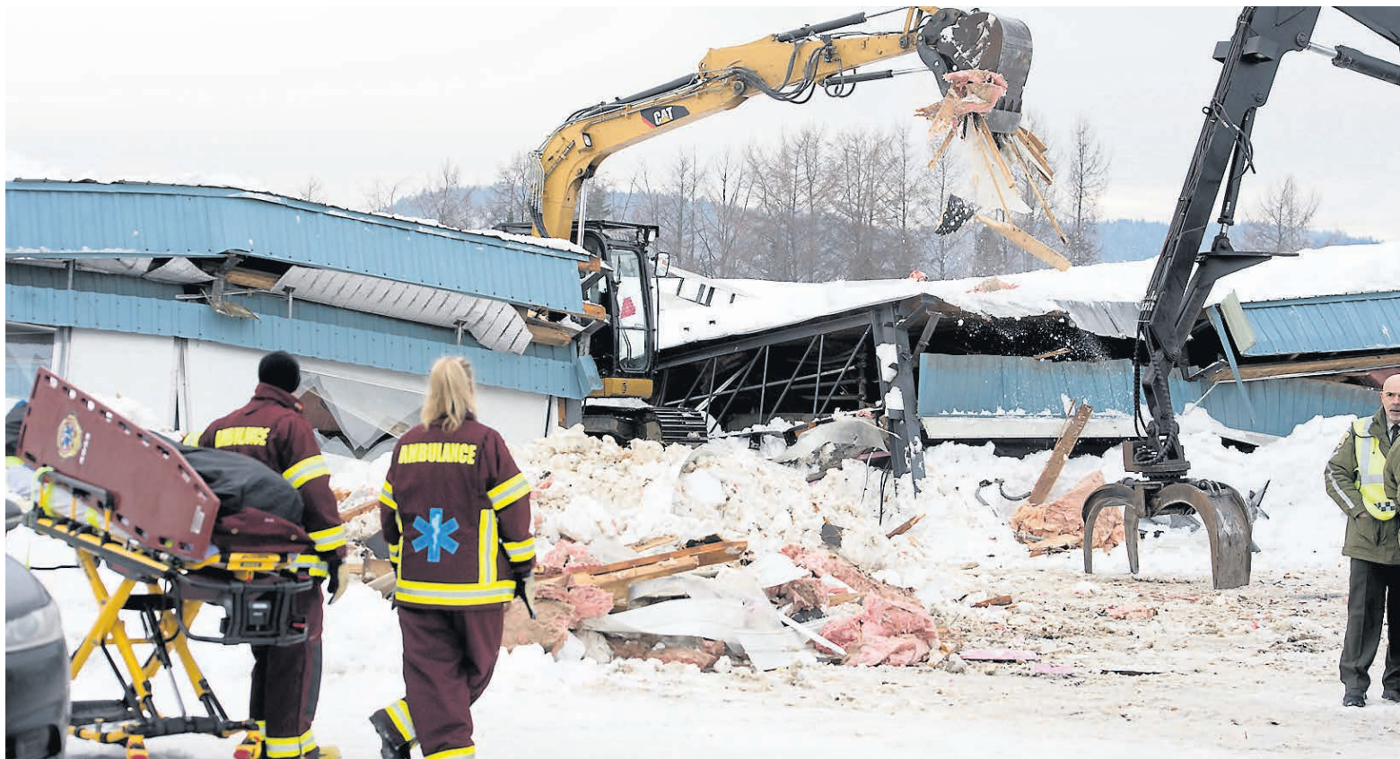
Des secours ont eu recours à deux pelles mécaniques pour dégager les débris avec comme objectif de retrouver le travailleur. — PHOTO: STÉPHANE LESSARD
