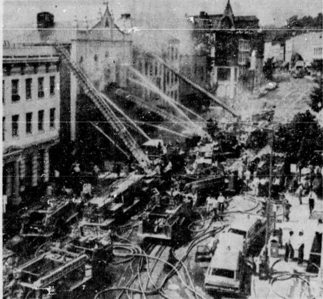
Washington (Téléphoto UPD) — Un incendie a lourdement endommagé un édifice construit avant la guerre civile américaine, soit en 1859. Environ deux cents pompiers ont combattu le sinistre qui a "dérangé" les citoyens cossus du quartier fashionable de Georgetown.
