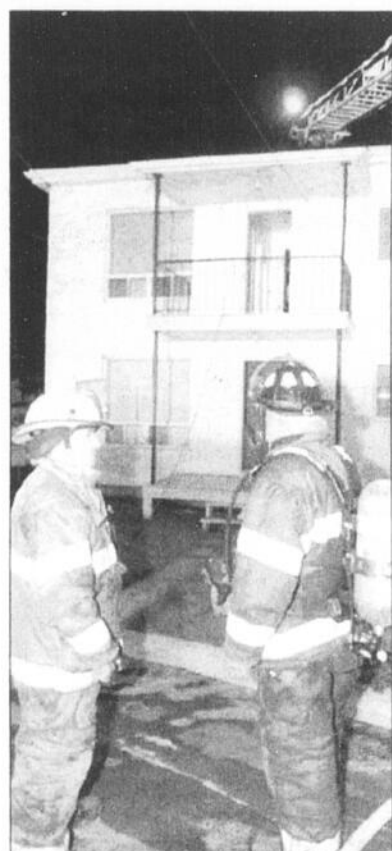
INCENDIE - Cette photographie captée hier soir, à Chicoutimi, montre que l'incendie survenu au 88 rue Sainte-Monique a été confiné dans l'entretroit. Il aurait été causé par un problème électrique.
