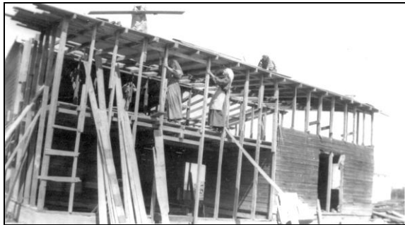
Construction d'un poulailler à Falher
