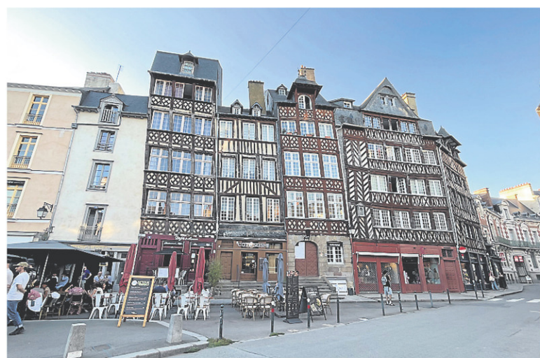
À Rennes, on construisait autrefois les maisons en bois, faute de pierres disponibles localement. — PHOTO LA TRIBUNE, JONATHAN CUSTEAU
