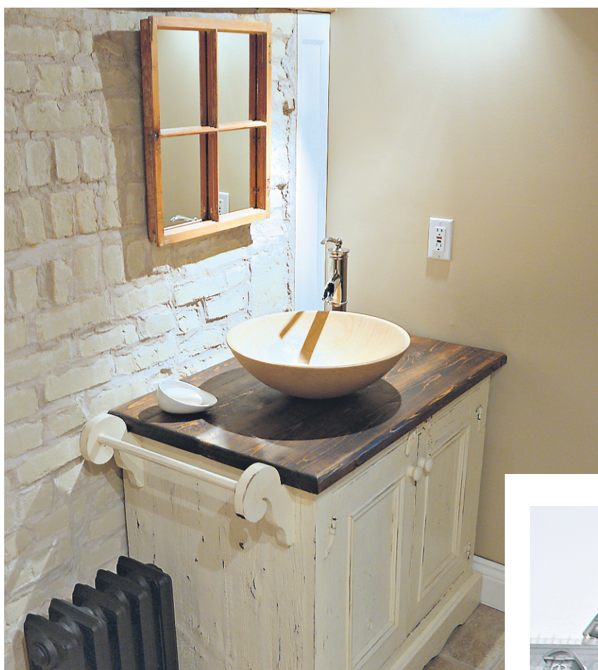
La salle d'eau du rez-de-chaussée. Un foyer désaffecté occupait l'emplacement du meuble de l'évier. Le calorifère récupéré (Ecorad) est muni d'un fil électrique qui chauffe l'huile dont il est rempli.
