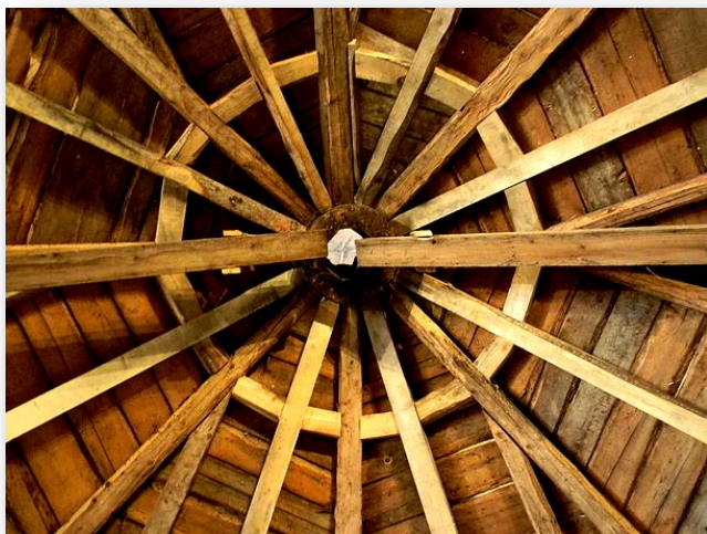
Charpente du toit
