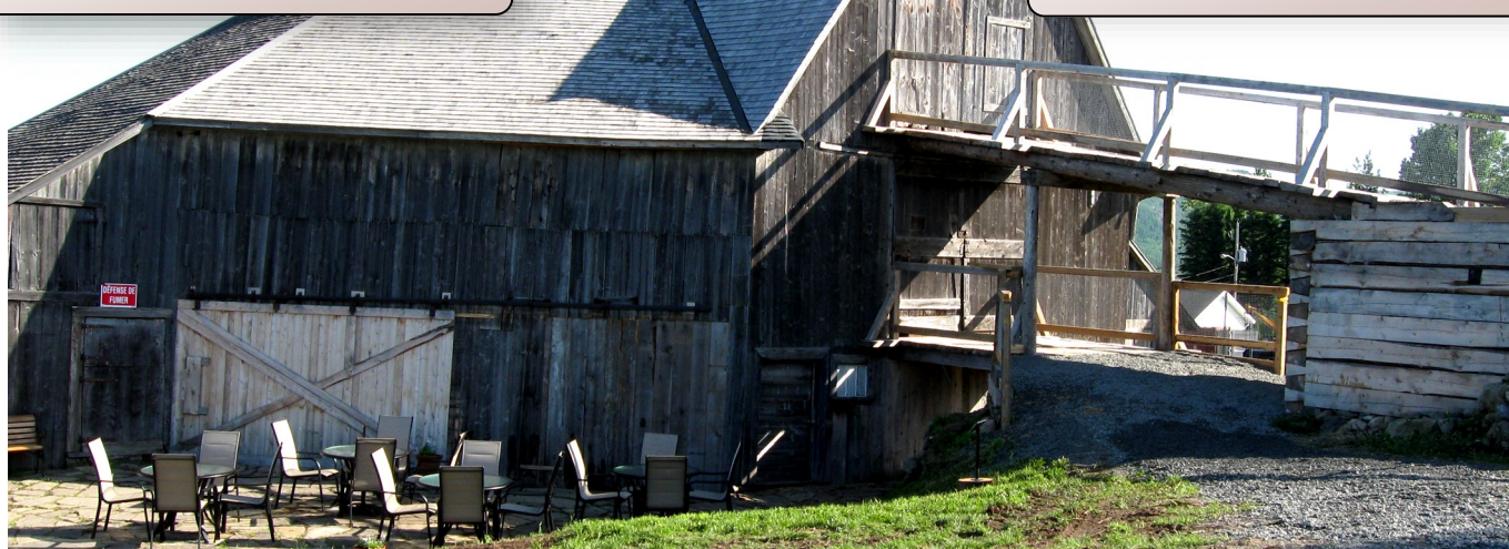
Côtés ouest et sud de la grange avec vue des deux ponts (Photo publiée avec l'autorisation du musée)
