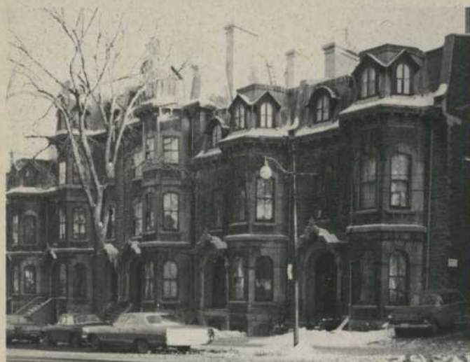
Façade de l'immeuble du Service de Ciné-photographie. Photo prise durant l'hiver 1969 quelques mois avant le déménagement à Duberger.
