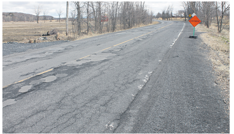
Des travaux auront lieu sur le rang des Vingt au cours de l'été. (Photo : Frank Jr Rodi)
