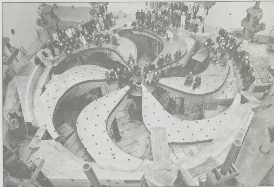
L'intérieur du cyclotron canadien Triumf au cours de sa construction.
