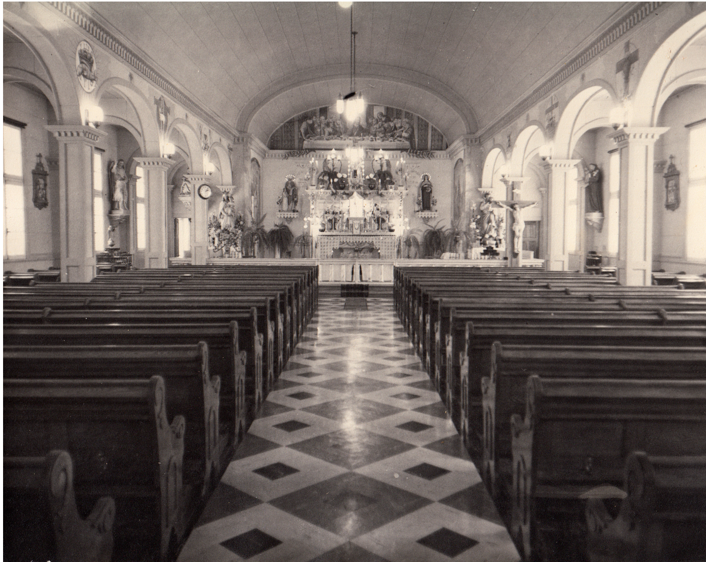
16 Vue ancienne de la nef, de la voûte et des bancs (Archives de la paroisse de Val-Morin)
