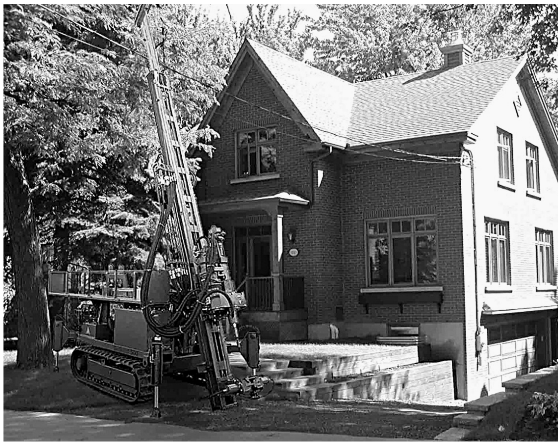
Foreuse servant à installer un système de chauffage géothermique dans une résidence
