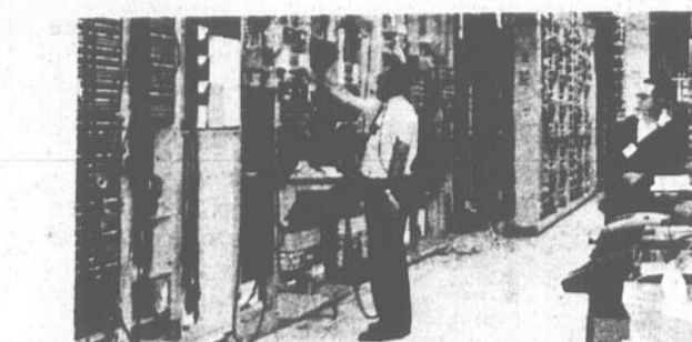
Dans cette salle, on assure les relations par radio, par liaison automatisé et par téletypewriter entre le Quartier général de la 22e Région du NORAD et ses nombreuses unités de radar et d'interception, de même qu'avec le Quartier général et toutes les autres régions du NORAD. Le Quartier général souterrain de trois étages de la 22e Région contient assez de matériel téléphonique pour desservir une ville de plus de 40,000 habitants.
