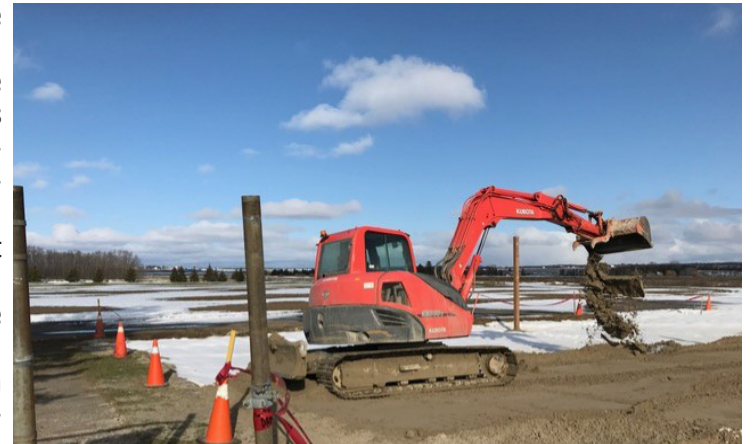
Les travaux en cours d'accomplissement. Gilles Lefebvre
