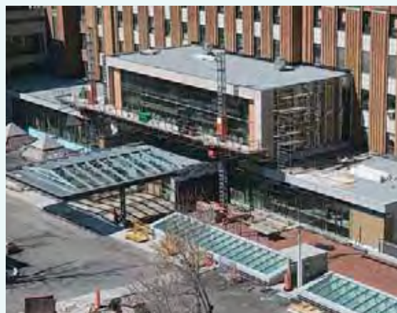
Le nouveau hall et la nouvelle entrée principale durant la dernière phase des travaux vers le milieu du printemps.
