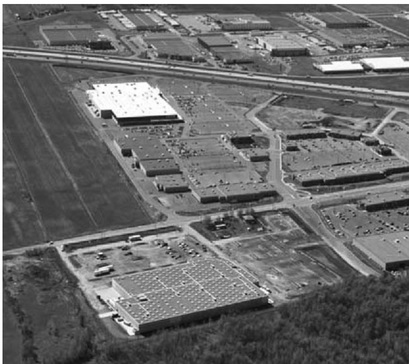
L'accès au Carrefour de la Rive-Sud à Boucherville via le Chemin de Touraine.
