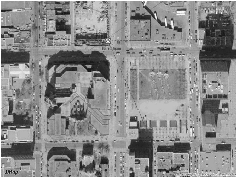
La place Émilie-Gamelin à Montréal. Au moment de la prise de photo, la Bibliothèque nationale du Québec n'était encore qu'un chantier.
