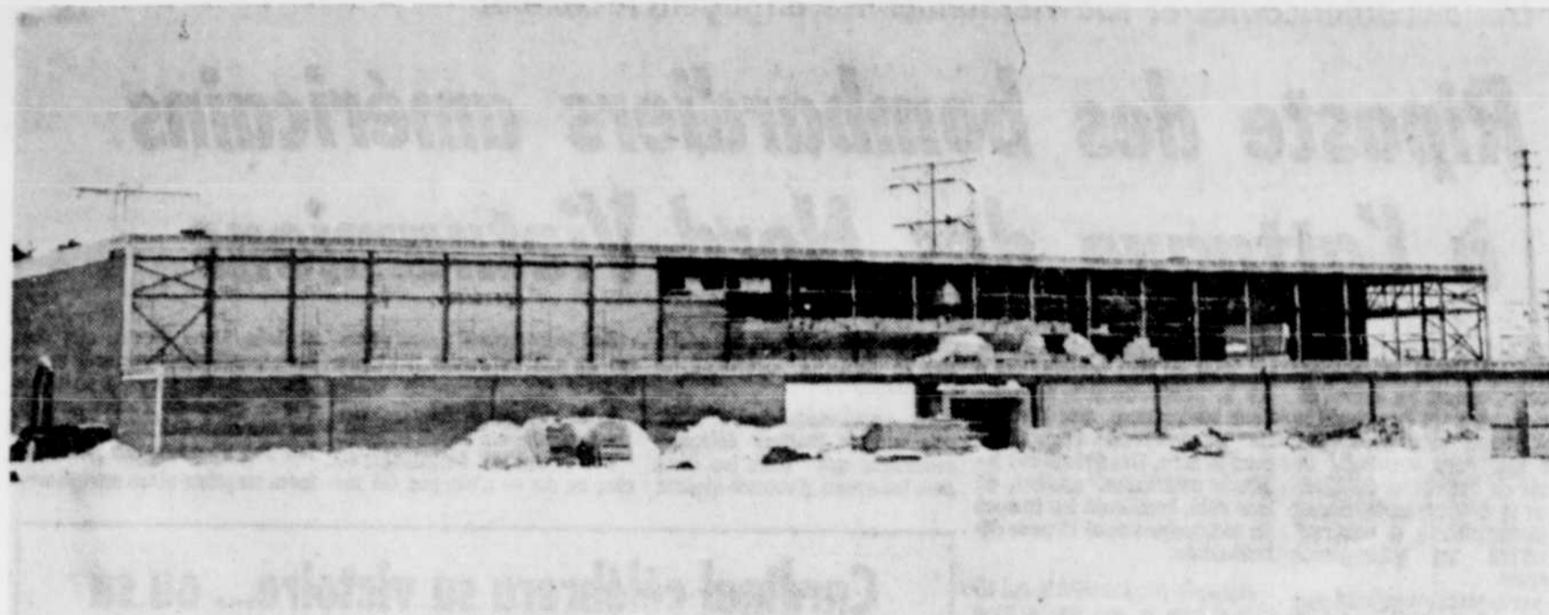
LE CENTRE RECREATIF "AUSSANT" que le conseil municipal de Saint-Joseph de Sorel fait ériger présentement au coût de $360,000 près de la piscine municipale. Les travaux de construction progressent nor-
