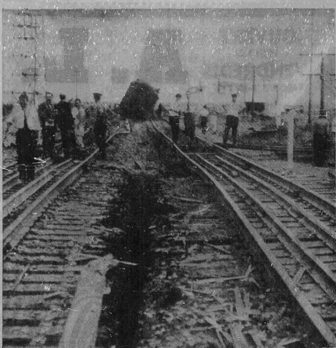
DERAILEMENT A BRONTE — Une profonde brèche dans le chevalet du pont qui passe au-dessus du ruisseau Bronte, près de Hamilton, a été la cause du déraillement d'un train de deux wagons-engins.
