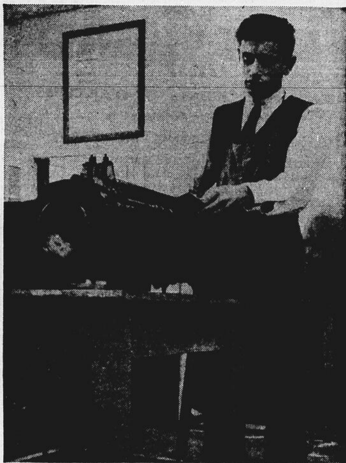
Un élève de la section de reliure de l'Ecole des Arts Graphiques procédant à l'encollage mécanique.
