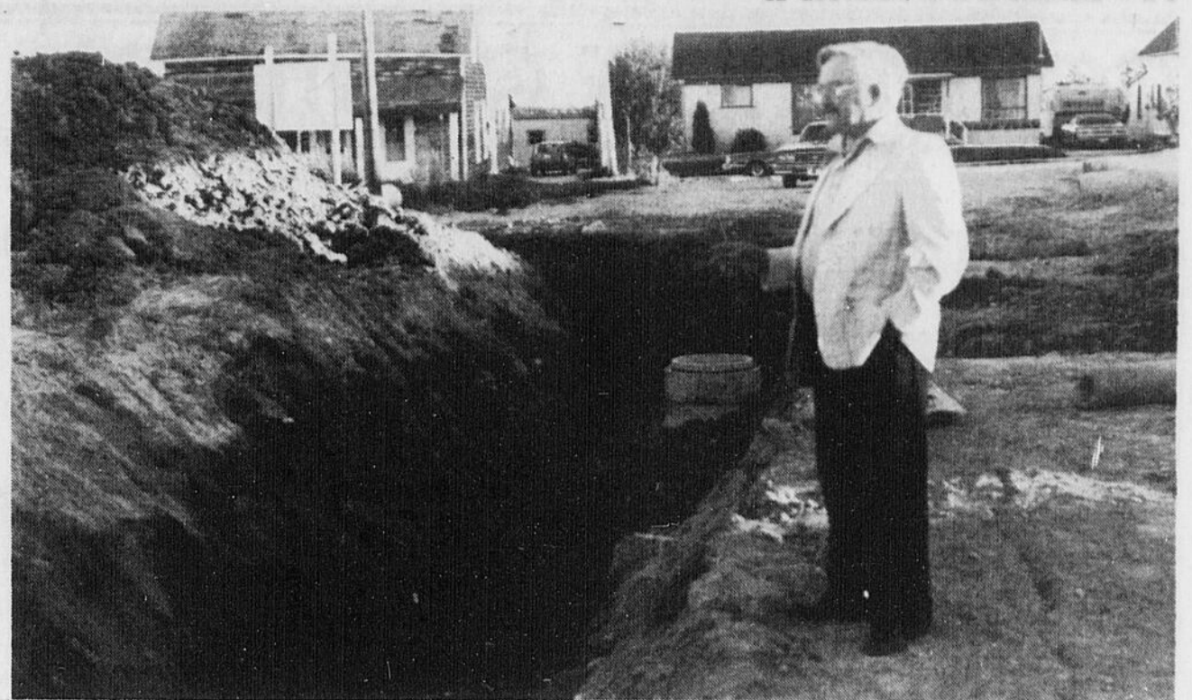
TRAVAUX — Le maire Fernando Brassard regardé ce canal géant où l'on y installera les services d'aqueduc et
