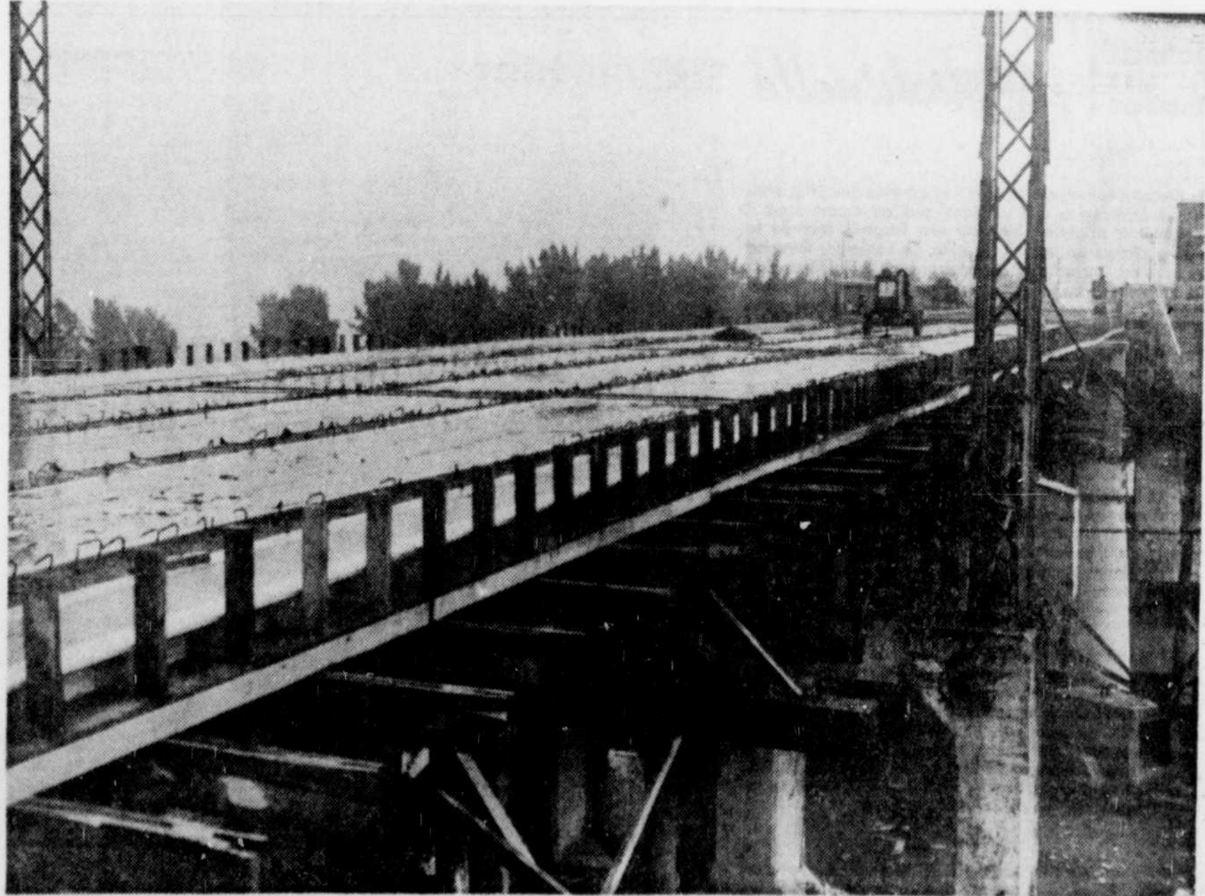
LES TRAVAUX de réparation entrepris au début d'août au Pont Turcotte de Sorel progressent normalement. Les ouvriers préparent actuellement les formes destinées à recevoir le béton pour le tablier. Ces travaux sont en voie d'exécution du côté de Sorel. Quant au côté de
