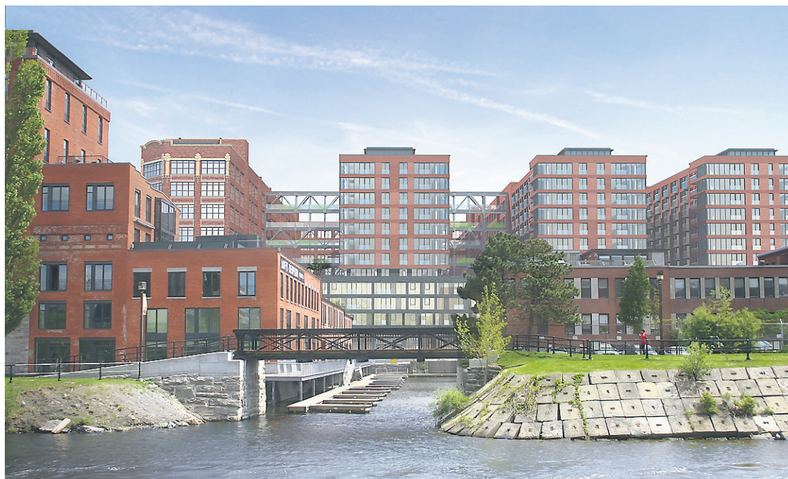
ILLUSTRATION FOURNIE PAR 2012 CONDOS NORDELEC Au Nordelec, dans Pointe-Saint-Charles, trois des ailes de l'édifice seront prolongées jusqu'à la rue Saint-Patrick pour y construire des appartements en copropriété. Trois étages de condos s'ajouteront, par ailleurs, le long de la rue Saint-Patrick et du canal de Lachine, qui sera plus facilement accessible.
