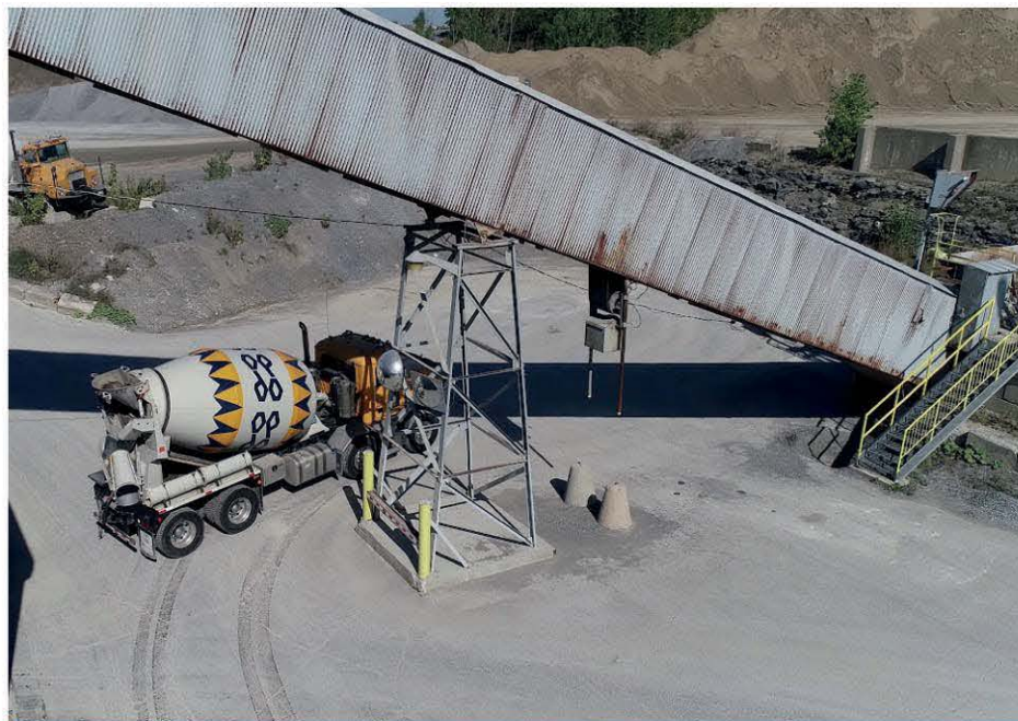
L'industrie du béton, Marcotte Systems, de Boucherville, a obtenu un prêt.
