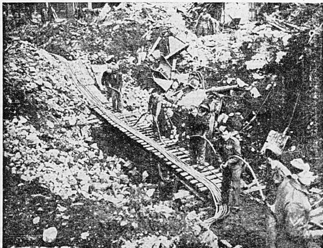
Au-dessus d'un cratère creusé par une bombe, dans les rues de Londres, des ingénieurs de l'armée ont installé un pont d'urgence et ils installent les câbles du téléphone et du télégraphe, afin de continuer le service.
