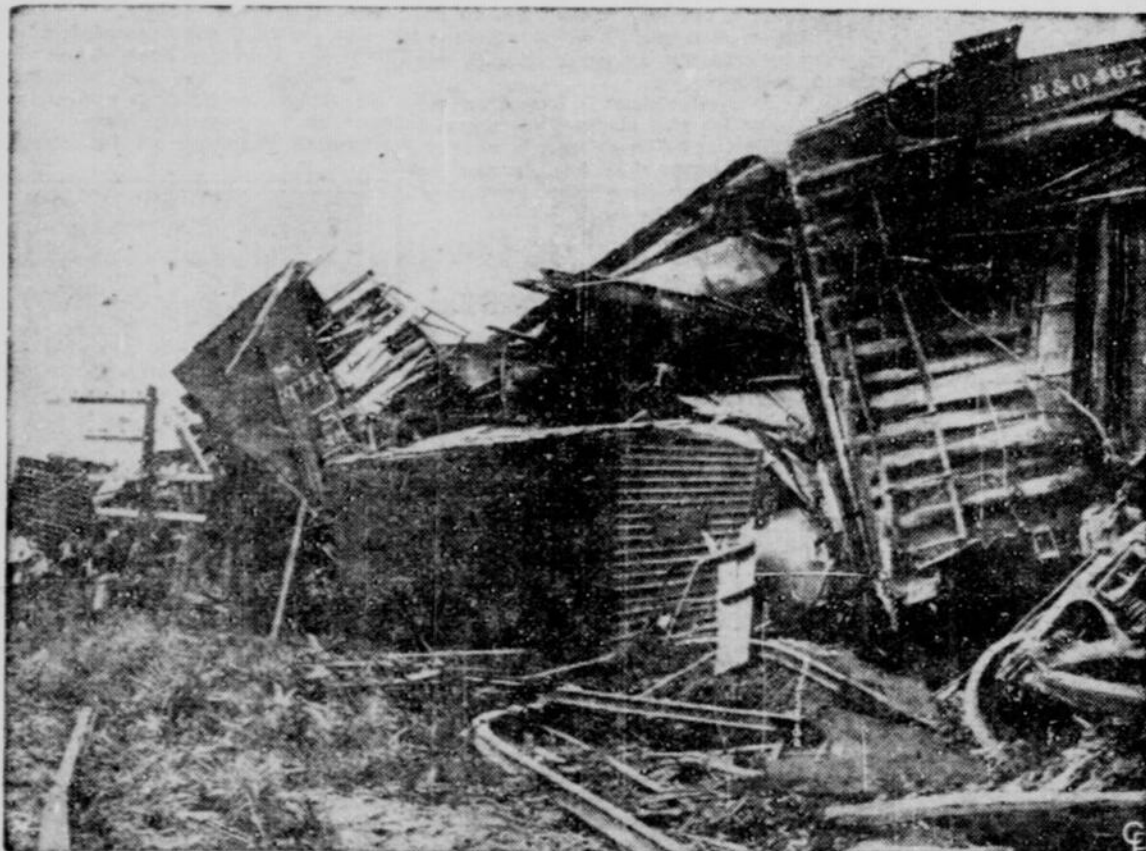
Six employés ferroviaires ont été blessés lorsqu'un convoi de passagers frappa un convoi de marchandises déraillé dont les débris encombraient la voie, aux limites de la ville de Miami, en Floride.
