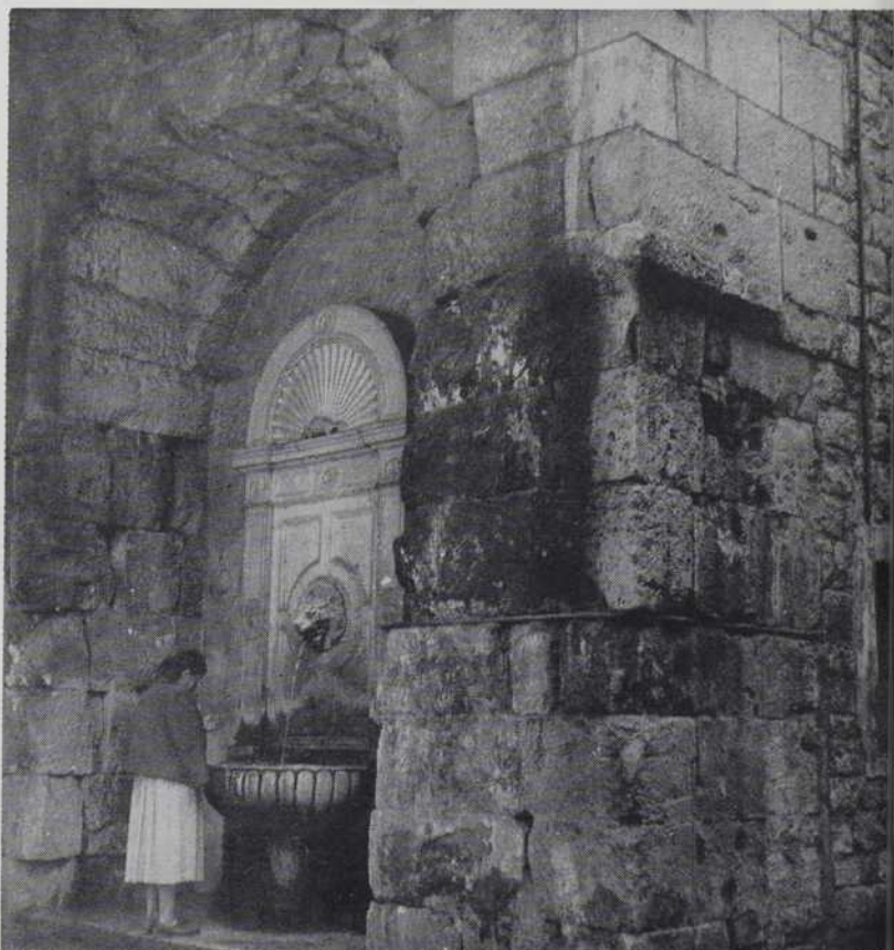
Une fontaine renaissance où les habitantes du quartier puisent volontiers de l'eau... ou rincent leur linge.
