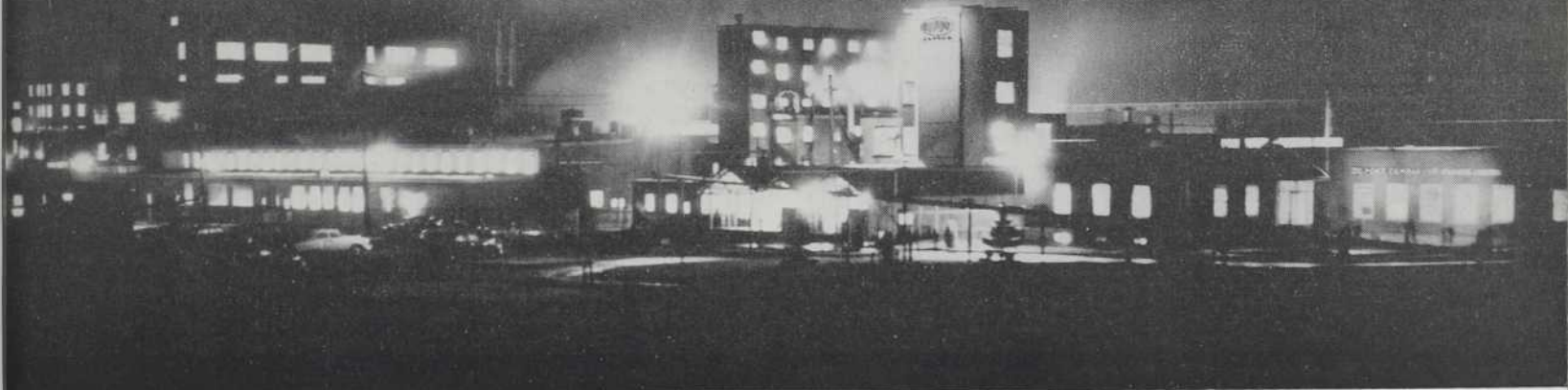
VOICI L'ASPECT QUE PRESENTENT, LA NUIT, LES ETABLISSEMENTS DE LA COMPAGNIE "DU PONT OF CANADA", A SHAWINIGAN-FALLS. ON Y FABRIQUE DE LA "CELLOPHANE" 24 HEURES PAR JOUR, 7 JOURS PAR SEMAINE.
