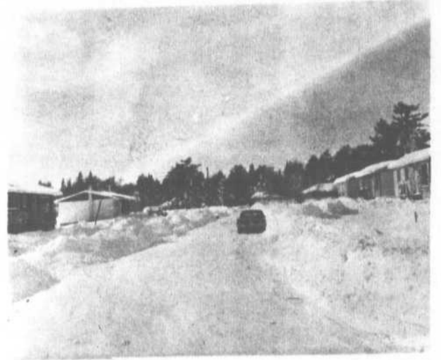
Un autre projet résidentiel qui progresse rapidement; celui de la Place Duland, dans le quartier no 2. Dumont & Landry y ont construit 27 bungalows en moins de 8 mois et projettent d'en construire au moins quarante en 1971.
