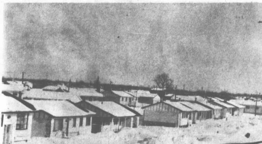
En l'espace de trois ans, Gaudreault Construction et Les Constructions Québécoises ont construit au-delà de cent maisons dans le quartier no 3. On n'aperçoit ici qu'une faible partie de cet important projet qui connaîtra en 1971, des succès encore plus éclatants.
