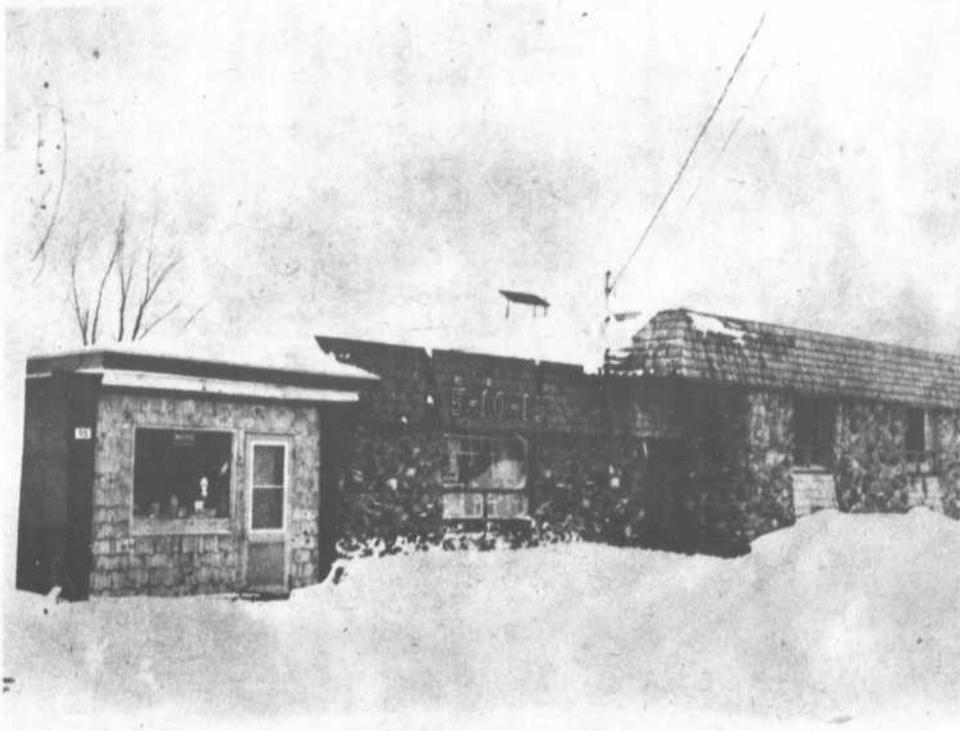
tions Masbec, installé dans une annexe à la résidence de M. René Pronovost. Sur la photo de droite la résidence de M. Théodore Pronovost laisse à peine deviner la présence d'un "5-10-15" qui offre pourtant un vaste choix à la clientèle.
