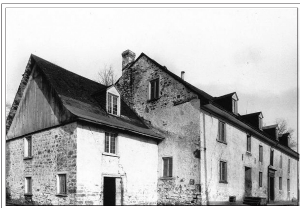
Moulin du Petit-Pré (1695) à Château-Richer.
