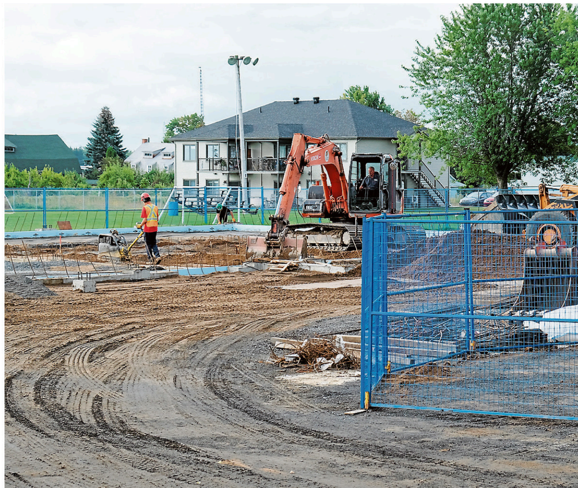
Entre-temps, les fondations sont terminées et la structure d'acier sera montée cette semaine, indique le directeur des Services techniques de Rougemont, Damien Sanschagrin. — PHOTO ALAIN DION
