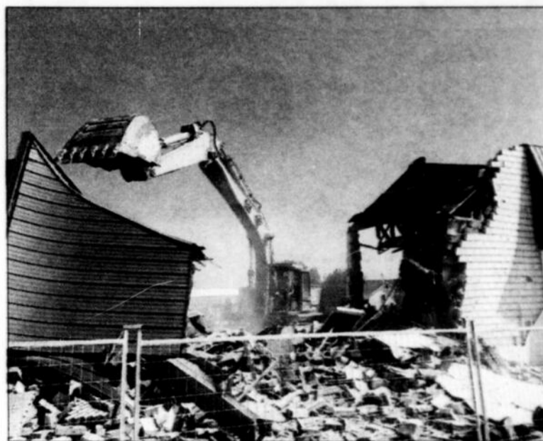
L'ancien bar terrasse l'Oxygène n'est plus. Le bâtiment a été démolé hier matin.
