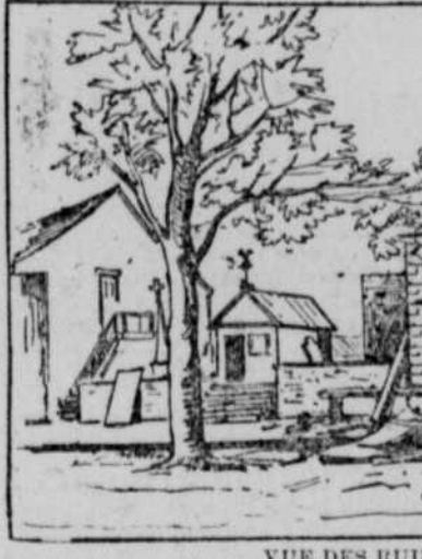
VUE DES RUINES DE L'ÉGLISE
