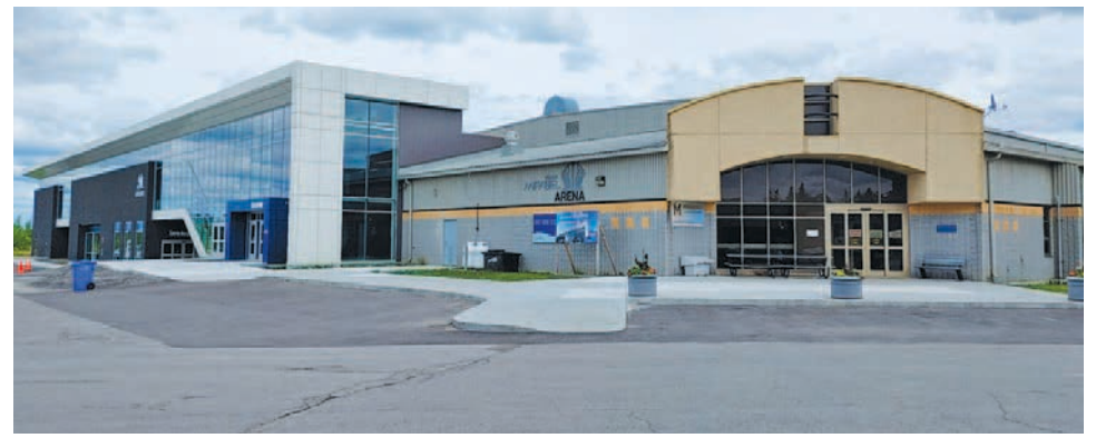
Le complexe Val d'Espoir à Mirabel est situé au 17700, rue du Val d'Espoir dans le secteur de Saint-Janvier.
