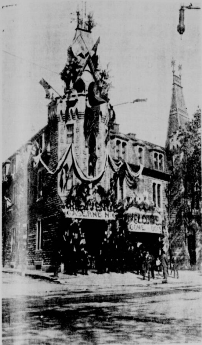
Poste du coin des rues des Allemands et Ontario
