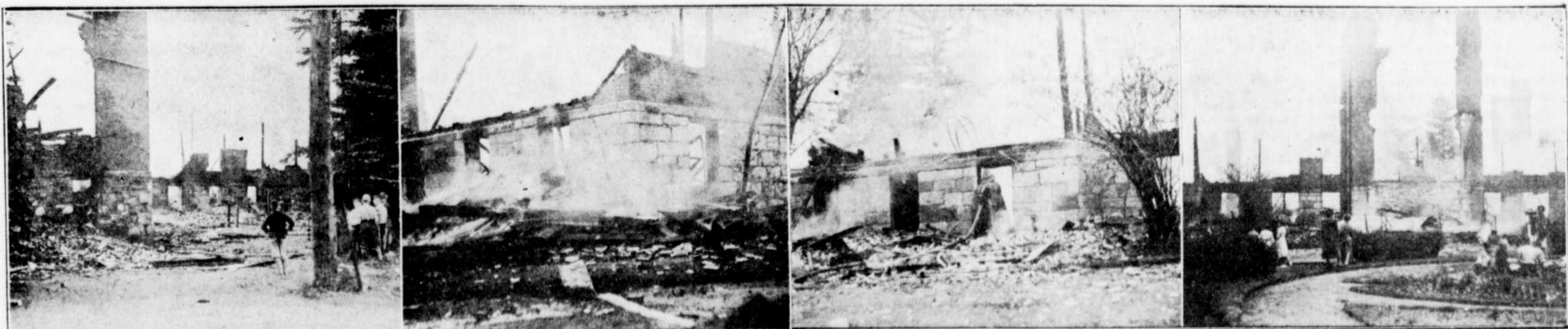
Photographies prises au cours de l'incendie qui détruisit de fond en comble, samedi après-midi, le Wesleyan College de Stanstead. (Photo la "Tribune")
