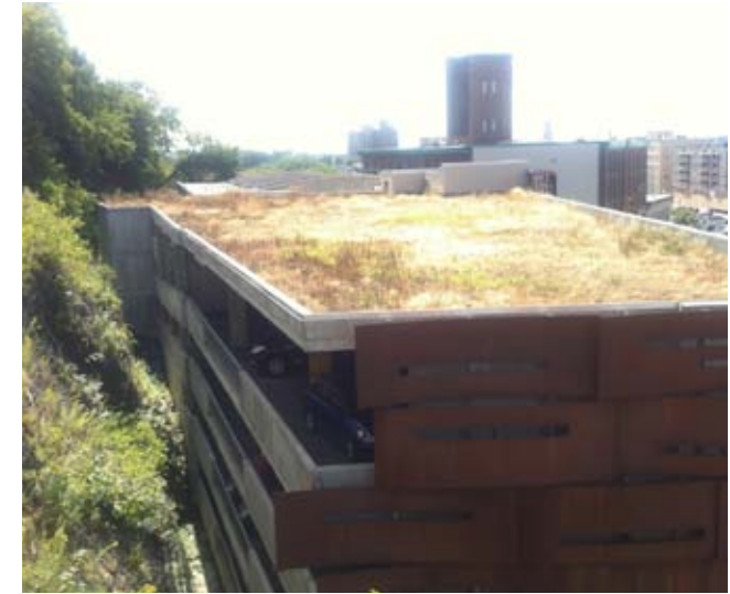
Image 24 : Toiture végétalisée et ouvertures des parois
