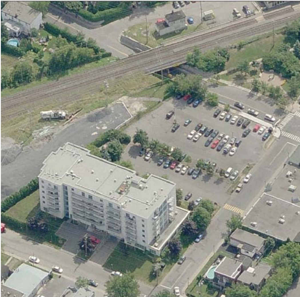
Figure 5 : Vue d'ensemble illustrant la situation existante
