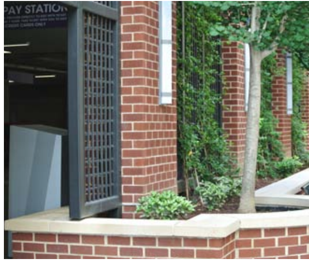
Image 43 : Entrée du stationnement souterrain
