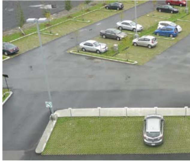
Image 7 : Présence de pavés gazonnés
