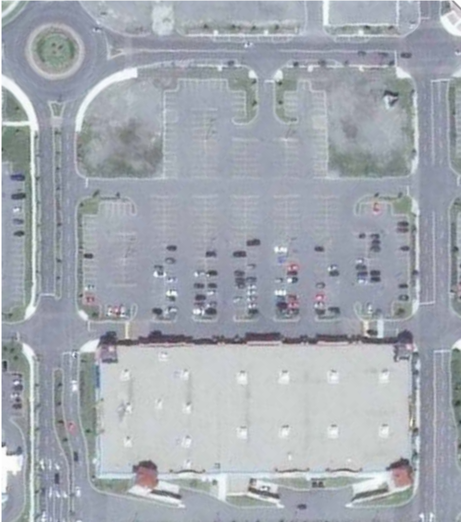
Figure 3 : Vue d'ensemble illustrant la situation existante
