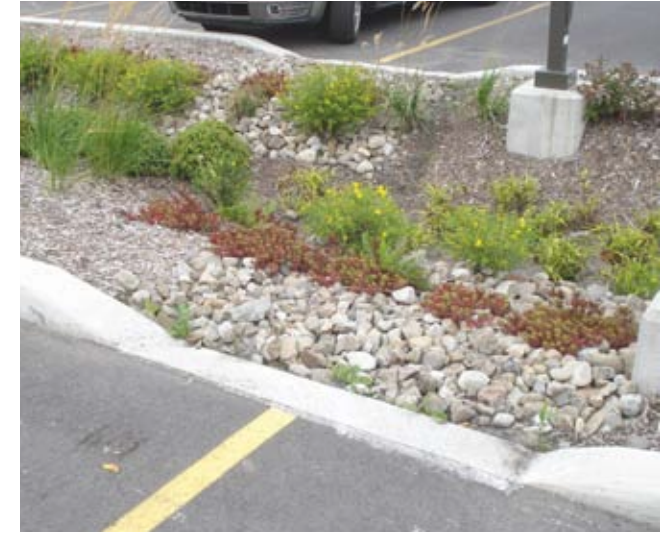
Image 4 : Récupération des eaux de surface dans l'îlot central
