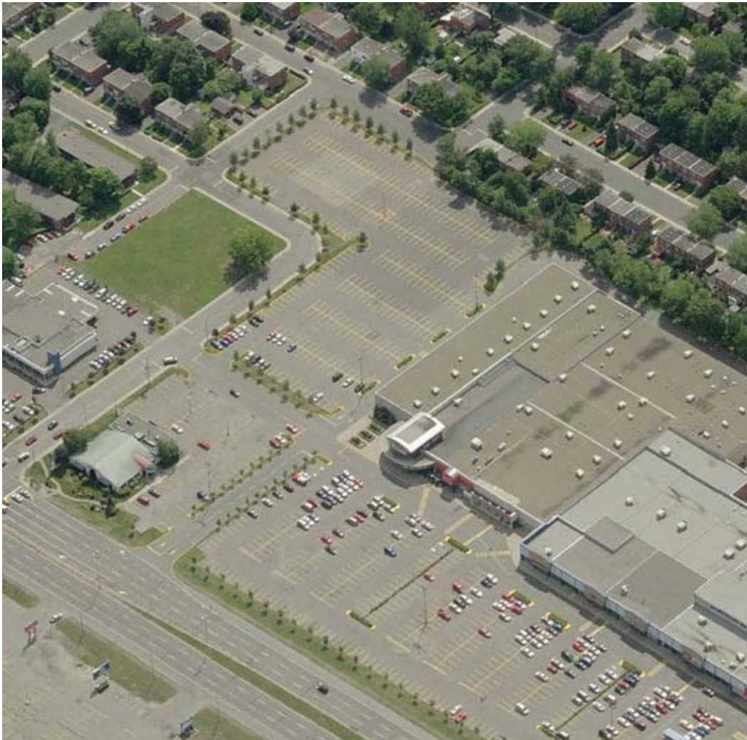
Figure 7 : Vue d'ensemble illustrant la situation existante
