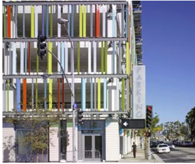
Image 31 : Stationnement de 8 étages avec commerces au rez-de-chaussée
