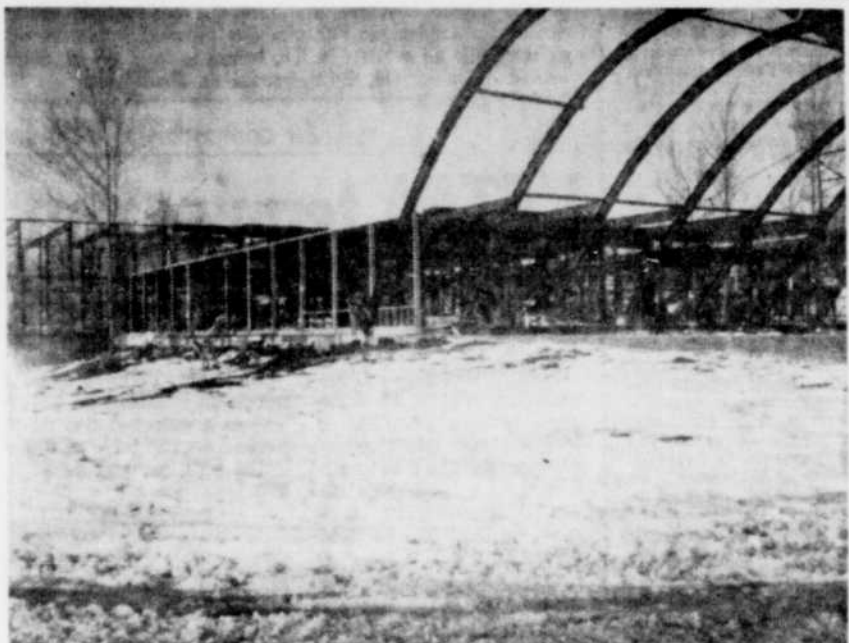
Ecole secondaire régionale. — La construction de l'école secondaire régionale de Richmond dont le coût approximatif s'élevait à $500,000 progresse rapidement. Cette institution comptera 16 classes régulières en plus d'un magnifique gymnase et de différents bureaux et services connexes pour le chapelain, les professeurs et la Commission scolaire. Le contrat de cette école a été accordé à l'entrepreneur Aimé Beaudet, de Warwick. (Photo La Tribune, par L. Trepanier)
